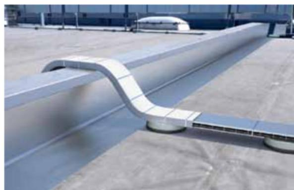
**Bild 4:** Verlegung von Leitungen mit Brandschutzumhüllung über eine Brandwand (Quelle OBO Bettermann)
