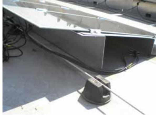
**Bild 18:** Abstand zwischen DC-Leitungen und Blitzschutzanlage nicht eingehalten (Trennungsabstand) (Quelle VGH)
