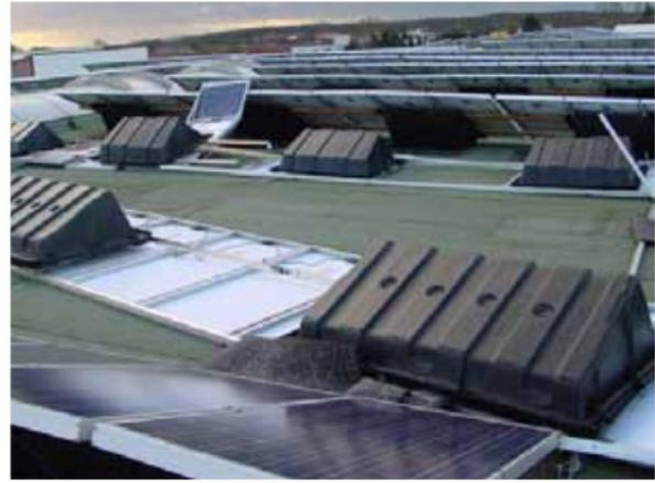
**Bild 8:** Sturmschaden durch Nichtbeachtung der Systemstatik (Quelle Mannheimer)
