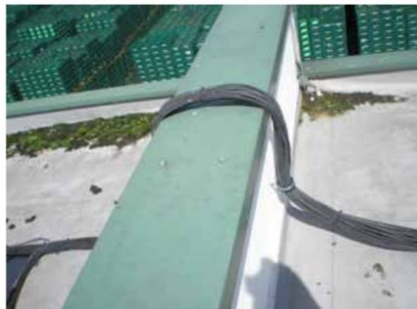
**Bild 3:** Nicht erlaubte Verlegung von Leitungen über eine Brandwand (Quelle VGH)
