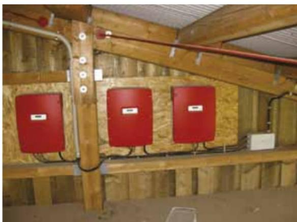
**Bild 9:** Montage von Wechselrichtern auf brennbaren Untergründen ist nur mit Zustimmung des Herstellers erlaubt. (Quelle Markus Scholand)
