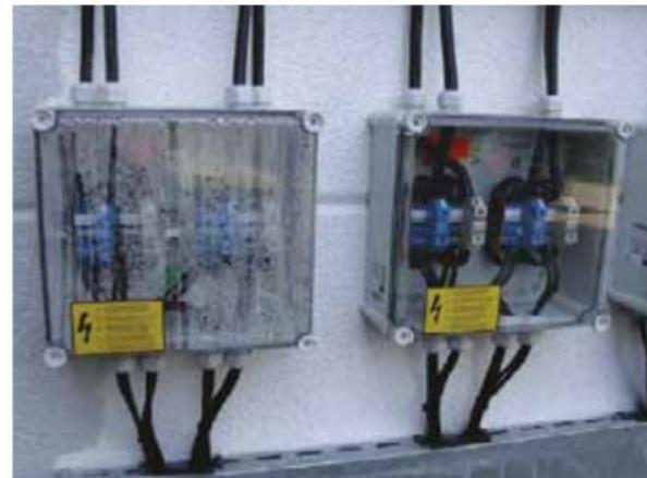
**Bild 15:** Kondenswasserbildung im Generatoranschlusskasten (Quelle Markus Scholand)
