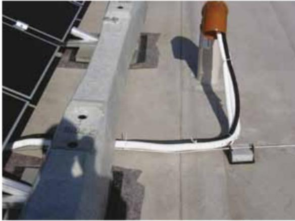
**Bild 17:** Abstand zwischen DC-Leitungen und Blitzschutzanlage nicht eingehalten (Trennungsabstand) (Quelle Markus Scholand)
