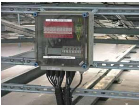
**Bild 19:** Generatoranschlusskasten mit Überspannungsschutzgeräten (Quelle Hensel)
